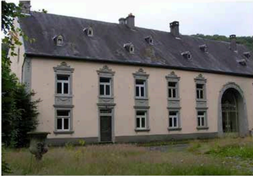
Aufbild 4 - Nachzustehende Vorderseite des Herrenhauses Mersch, 2013
