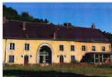
Aufbild 5 - Südliche Rückseite des Herrenhauses Mersch vor der Restaurierung Foto © Dr. Thomas Lugin, Diplom Restaurator
