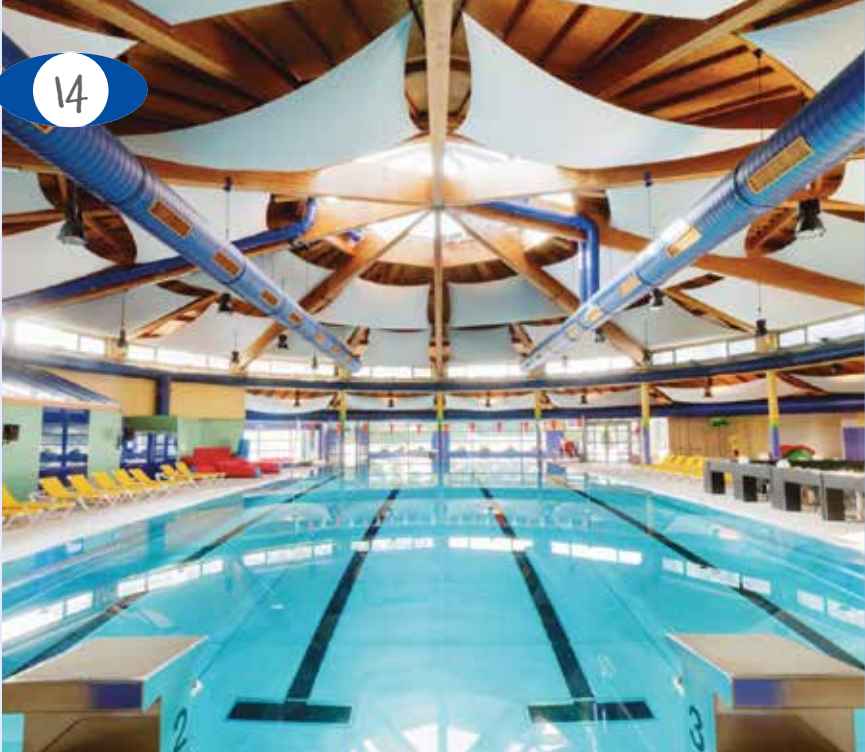
Le bassin de natation - Réidener Schwemm
