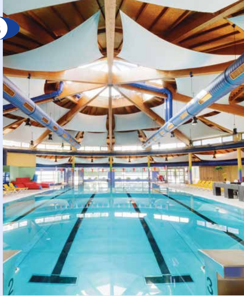
Le bassin de natation- Réidener Schwemm
