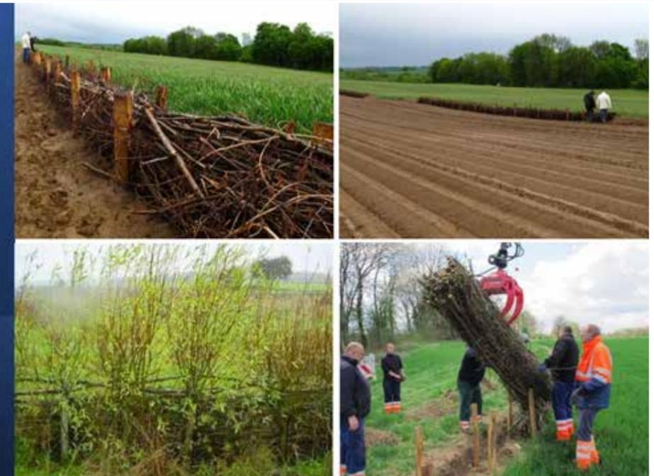
La technique des fascines (Totholzhecken) permet de retenir les terres avant qu'elles ne se concentrent en coulées de boues pouvant provoquer d'importants dégâts. *\*(voir image 2)*
