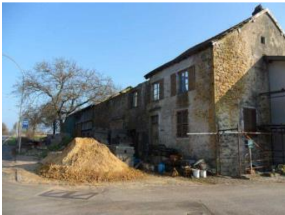
Ferme implantée en face de la zone d'étude.
